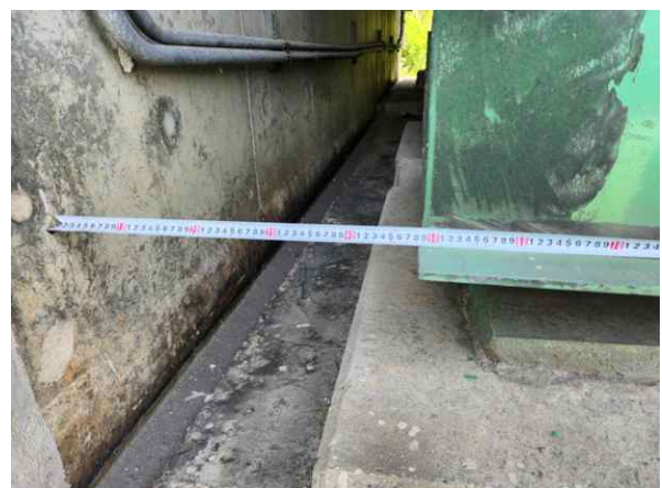
거더 이동량 측정
